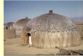
Casas zulúes, construidas mediante capas de paja atadas a una estructura de ramas
