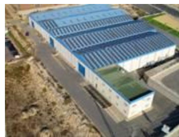
Naves edificadas en suelo industrial
