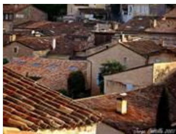
Zona del casco antiguo con uso residencial
