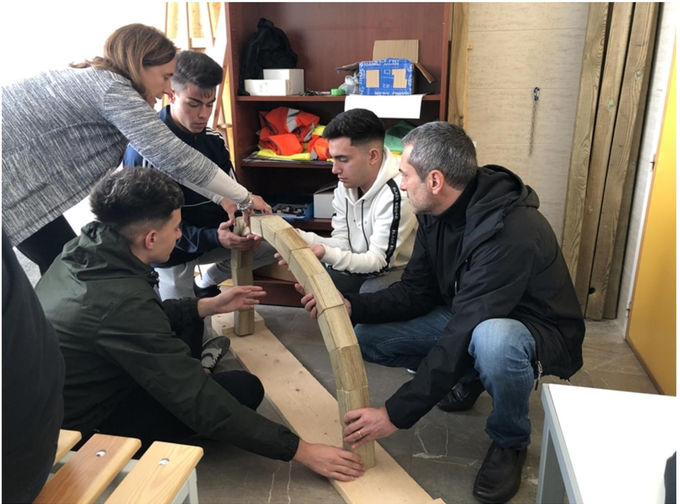
**Construcción del puente de Leonardo da Vinci, sin ningún elemento de unión.**
